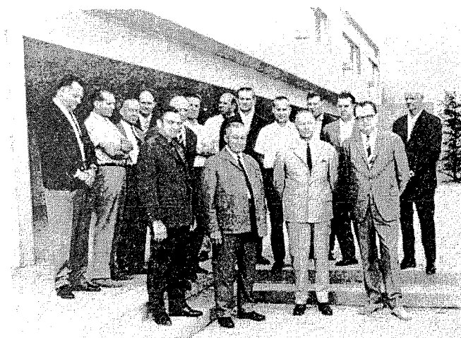
Vor der Übergabe der neuen Mittelpunktschule „Oberer Hüttenberg“ Pohl-Göns/Kirch-Göns, besichtigten die Schulverbandsvertreter zusammen mit dem Architekten noch einmal den Komplex. — Am Sonntag wird die Schule um 10 Uhr ihrer Bestimmung übergeben.
