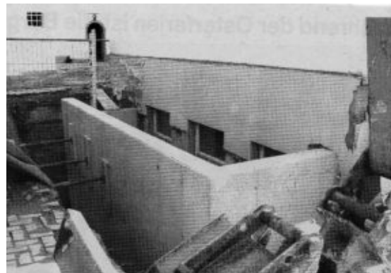
Der neu angelegte Treppenabgang zum Bürgertreff Pohl-Göns
