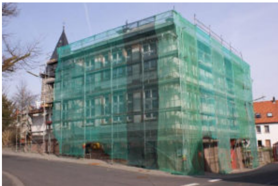
Das eingerüstete Kirch-Gönser Bürgerhaus
