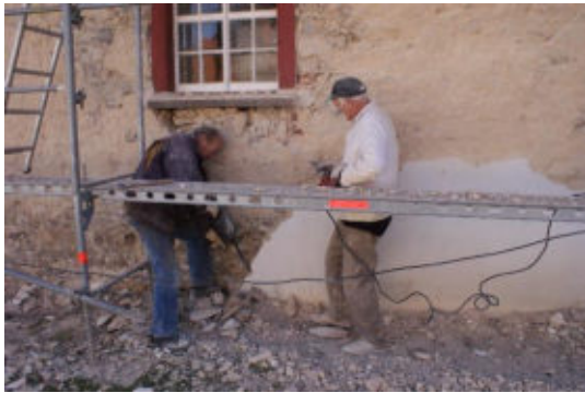
Gerhard Reinhard (l.) und Walter Jung (r.) bei Abbrucharbeiten an der evangelischen Kirche Kirch-Göns
